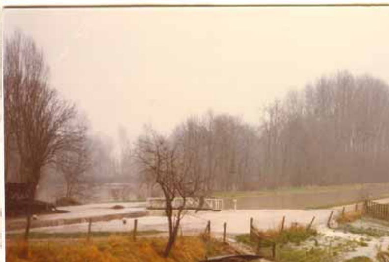
10 janvier 1982 - A l'écluse de "Brisebarre", le Loing naturel a inondé le canal du même nom.
