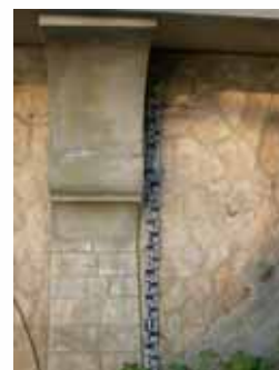
L'échelle de crue au pont de FONTENAY-sur-LOING
