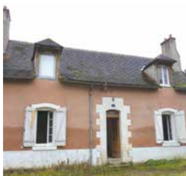
Pont de Nargis
