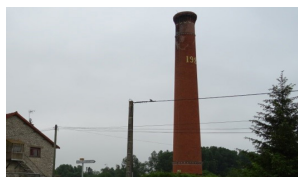
Cheminée en briques de l'ancienne distillerie, Sceaux-du-Gâtinais
