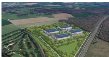
Future zone de l'EcoParc, Ferrières-en-Gâtinais
