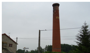
Cheminée en briques de l'ancienne distillerie, Sceaux-du-Gâtinais
