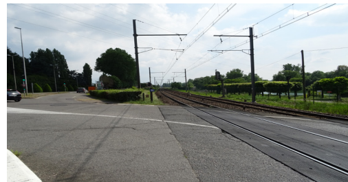
RD 2007 et ligne SCNF, Fontenay-sur-Loing
